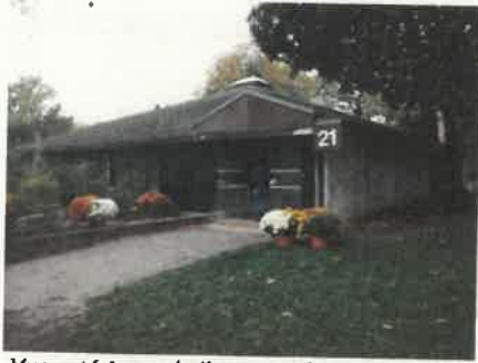
Vue extérieure de l'ouvrant de désenfumage au faitage
