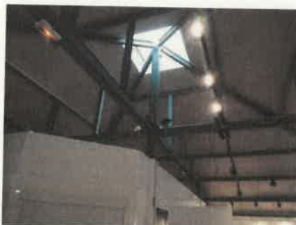
Vue intérieure de l'ouvrant de désenfumage au faîtage
